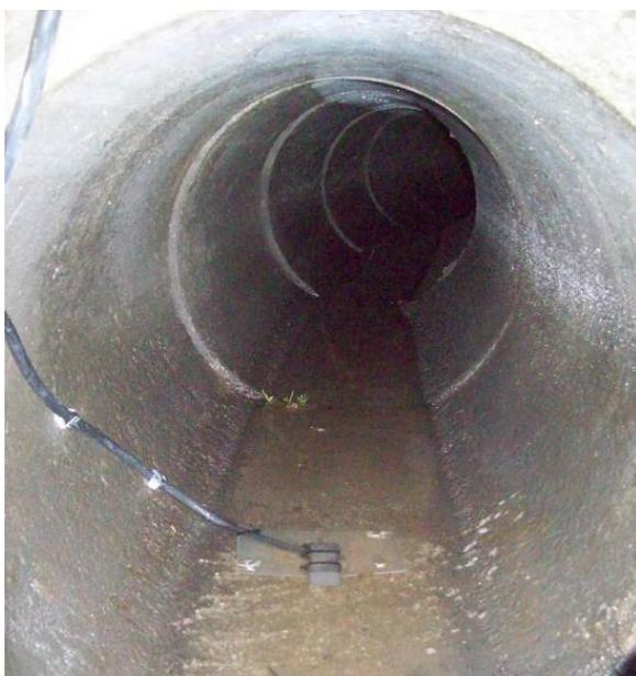
**Figura 8.- Conducto de vertido hacia el mar en la sección de control**
